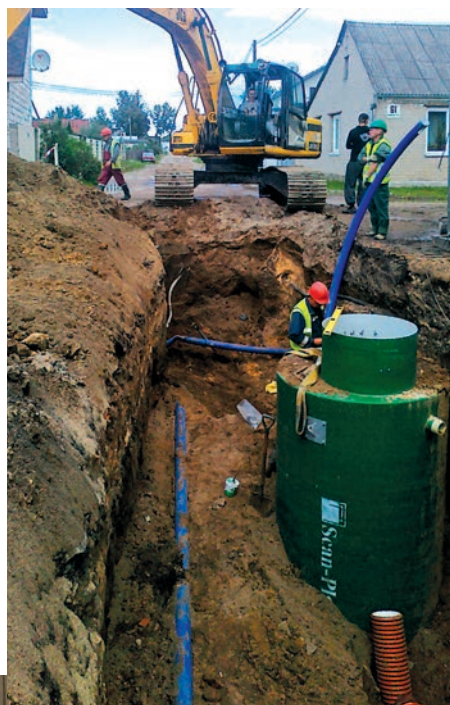
Kanalizācijas sūkņu stacija ar 2x2,4 kW sūkņiem.
